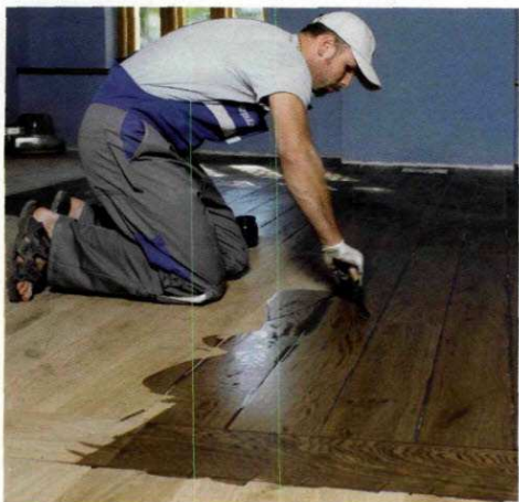
Aplikacja oleju odbywa się za pomocą różnych narzędzi, m.in. szpachli lub wałków.
